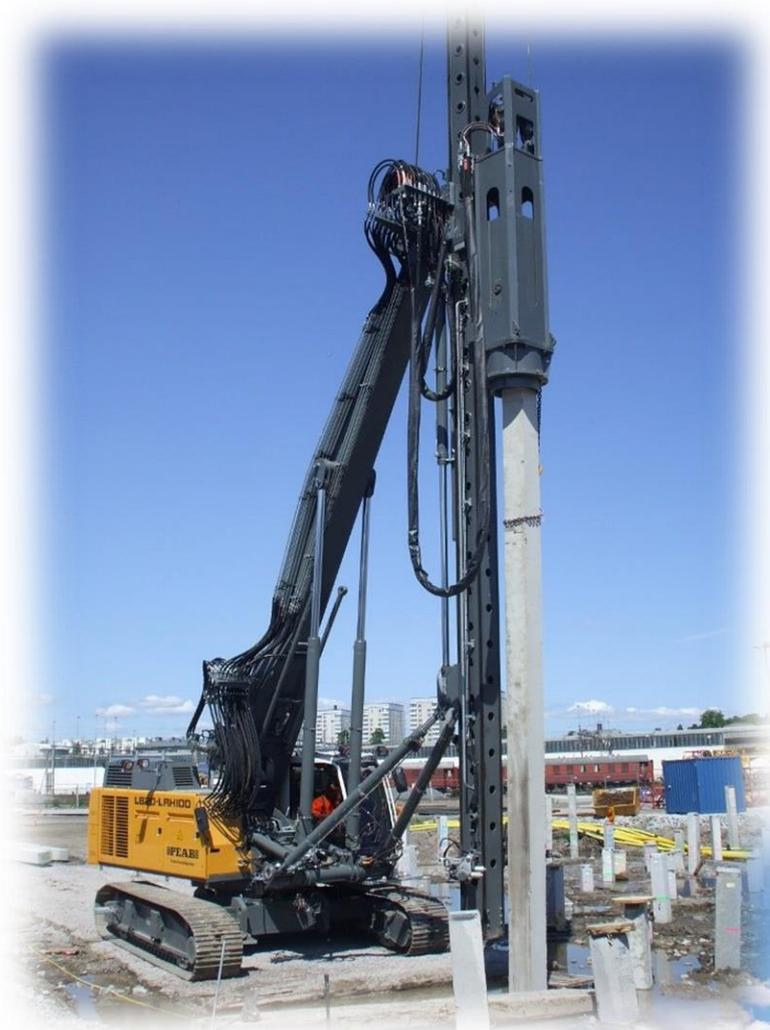
Копер сваебой - машина для погружения железобетонных свай и шпунта методом ударной забивки либо вибрационных воздействий. Это наиболее распространённый вид техники в свайных работах, который обеспечивает выполнение всех технологических операций при забивке свай.
